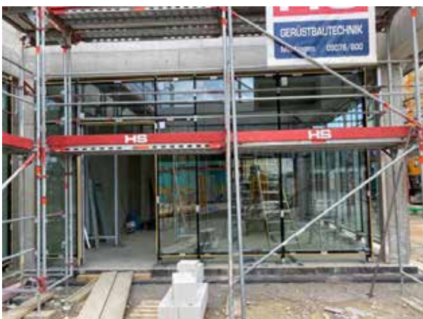
Les vitres sont montées au rez-de-chaussée. C'est ici que se trouvera l'entrée principale.
