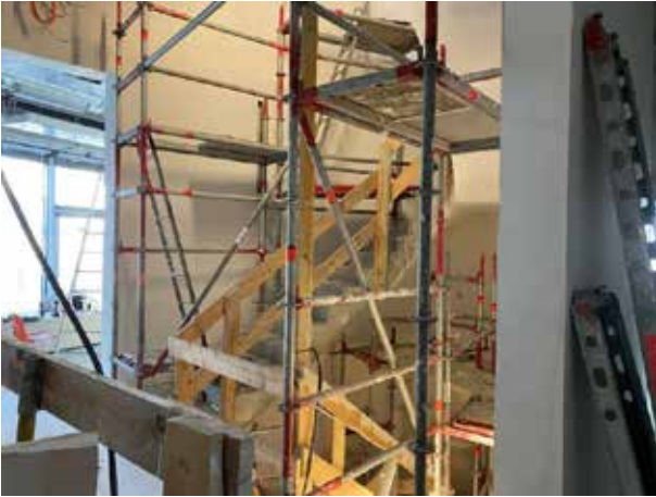
La cage d'escalier est temporairement impraticable en raison de la mise en place d'un échafaudage pour le crépissage.
