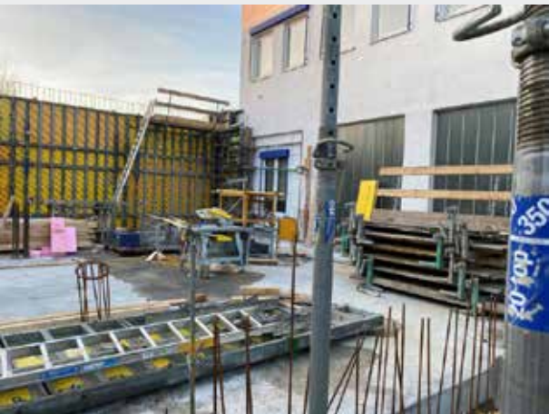
Vue de l'extérieur de la future entrée. À droite sur la photo, notre ancien bâtiment, qui sera entièrement rénové après l'achèvement de l'extension.
