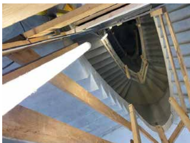
Vue d'en haut de la cage d'escalier.
