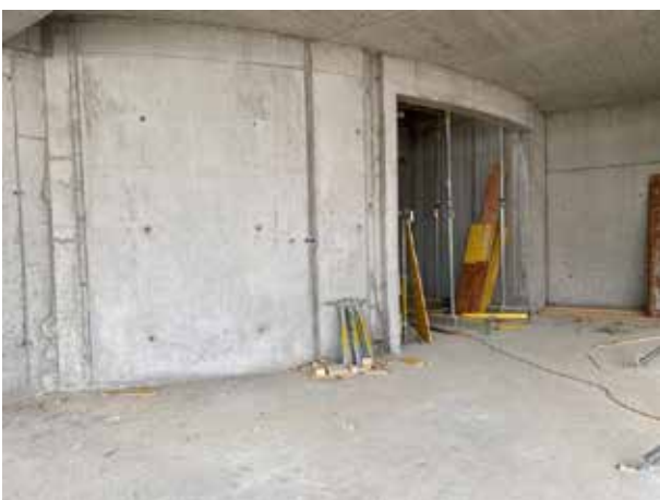
Nous nous dirigeons vers l'escalier, qui sera plus tard aussi lumineux que les autres pièces, à travers un dôme de verre au plafond.
