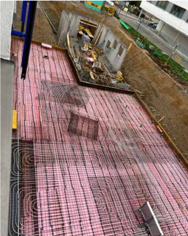
Les circuits de chauffage pour l'activation du noyau de béton dans la zone arrière du sous-sol ont été installés.
