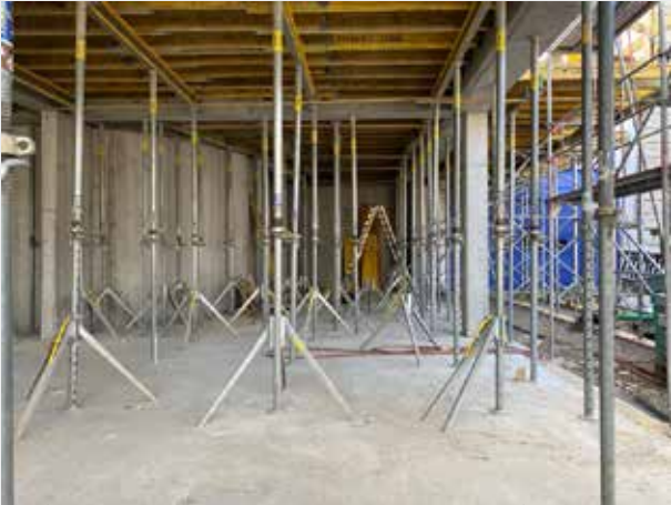
La future entrée et la zone d'exposition. La (future) façade vitrée à droite laisse entrer beaucoup de lumière.
