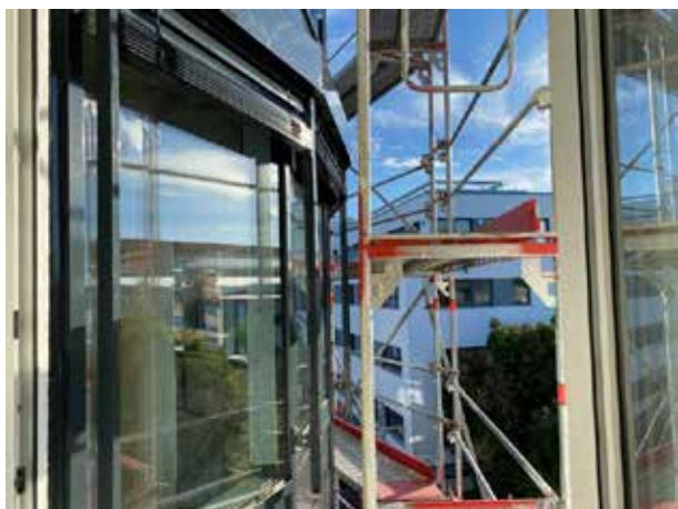
Les stores solaires sont installés
