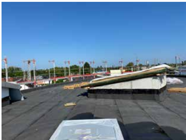
La cage d'escalier est encore recouverte de films. Plus tard, la lumière pénétrera dans la cage d'escalier à travers une grande couverture en verre.
