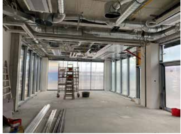
La pose du plafond chauffant/rafraîchissant est en cours dans la zone multifonctionnelle.
