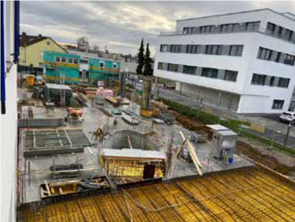
Après les vacances d'hiver, les travaux se poursuivent à plein régime dans la zone avant. Seul l'arrière de l'entrepôt attend encore l'installation des circuits de chauffage. Un détail : l'escalier elliptique avec le "pont" qui mène d'un côté à l'autre.
