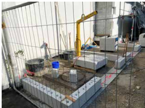
Les murs de l'extension sont maçonnés - mais le toit a finalement été bétonné à nouveau (pour des raisons de protection incendie).
