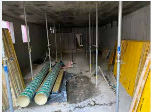
Vue de la partie avant du sous-sol. C'est ici que sera situé le système de ventilation.
