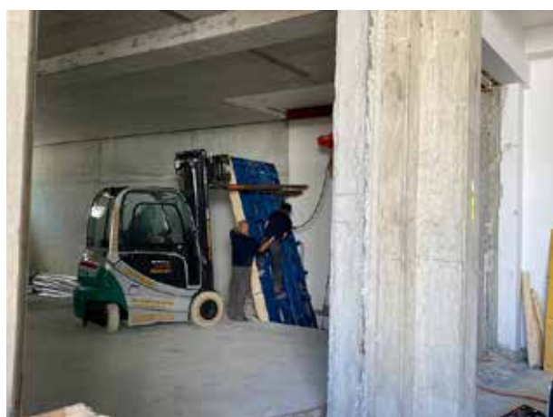
La mise en place des parties latérales est un travail millimétré.
