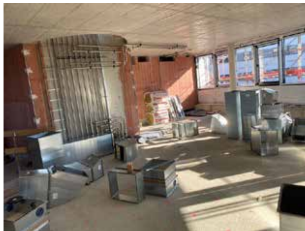
Dans le bureau paysager du premier étage, les murs en béton sont déjà apprêtés et les gaines de ventilation sont montées.
