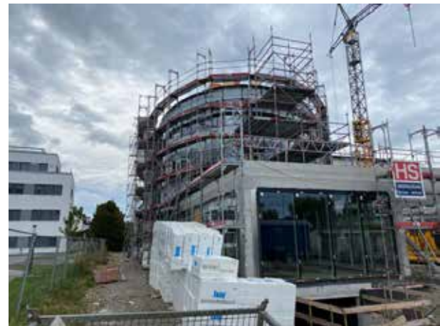
Une partie de la façade est encore recouverte d'un film de protection, mais on peut de plus en plus deviner à quoi elle ressemblera un jour.
