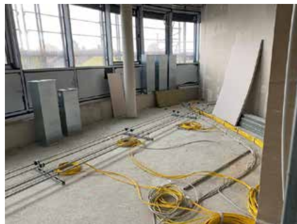
Au premier étage, d'autres conduites et câbles sont toujours en cours de pose au sol.
