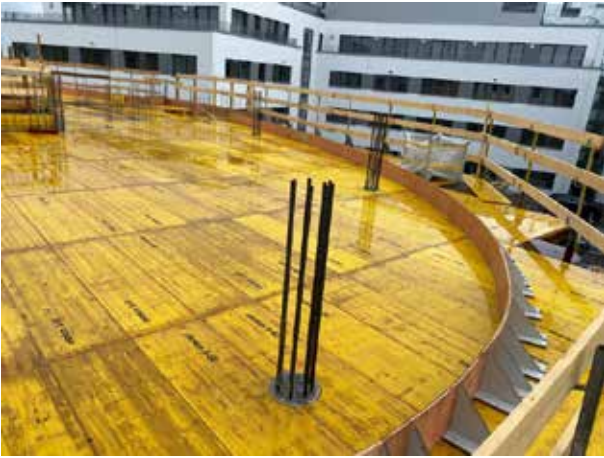
Le coffrage elliptique du plafond du 1er étage est réalisé...
