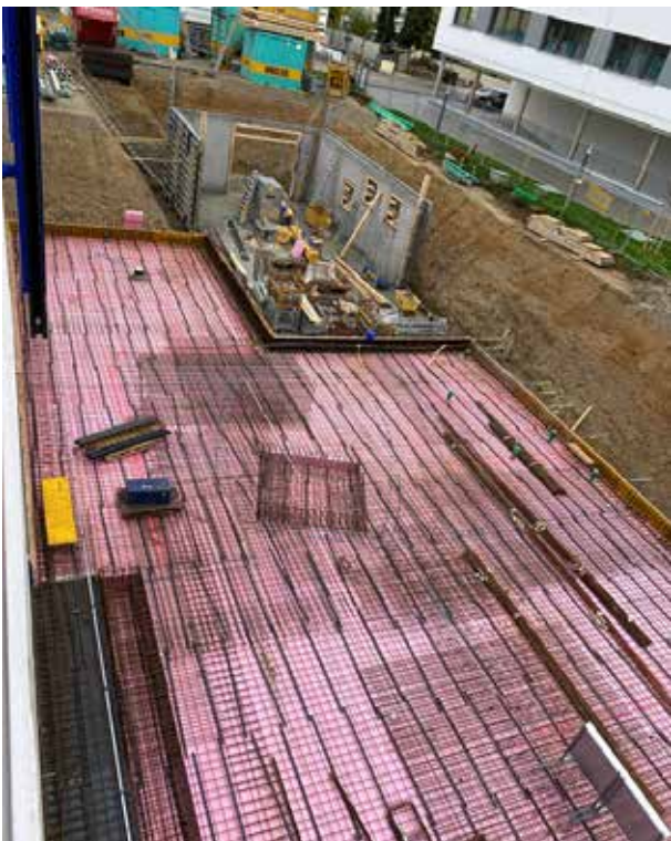
Les premiers murs du sous-sol sont en place.
