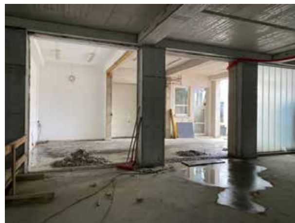
Le raccordement du nouvel entrepôt à l'ancien bâtiment est ouvert, à l'exception d'un ancien élément de paroi qui doit encore être enlevé. Il reste ensuite à démolir l'ancien revêtement de goudron et à réaliser une nouvelle dalle.
