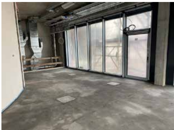
Et photographié du même endroit vers l'arrière en direction de l'ellipse de la cage d'escalier.
