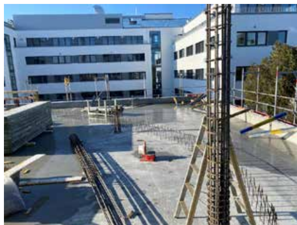
Les colonnes supportant le plafond du 1er étage sont ensuite créées.
