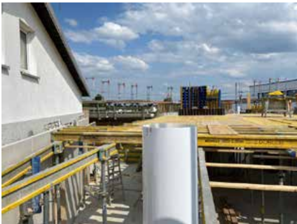
C'est ici que le nouveau bâtiment "s'amarre" au bâtiment existant.
