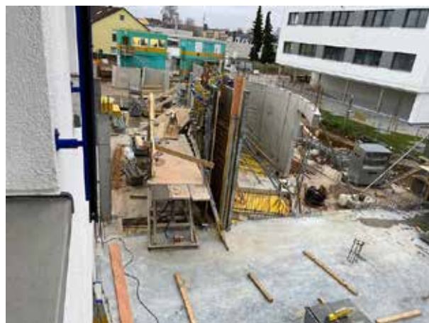
Une autre vue de l'arrière du futur escalier. Il ne manque qu'un point où le revêtement extérieur n'a pas encore été posé, le bétonnage du mur de l'escalier pourra donc bientôt commencer. Le rez-de-chaussée prend forme et bientôt les photos du chantier devront être prises depuis le 2e étage de l'ancien bâtiment.
