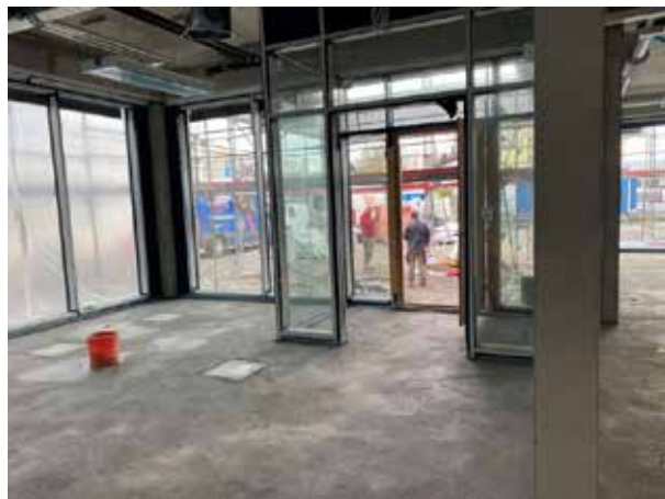
La chape a été posée sur tout le rez-de-chaussée. Les pièces laissent de plus en plus présager de ce à quoi elles ressembleront plus tard. Ici, la vue de l'intérieur sur l'entrée.
