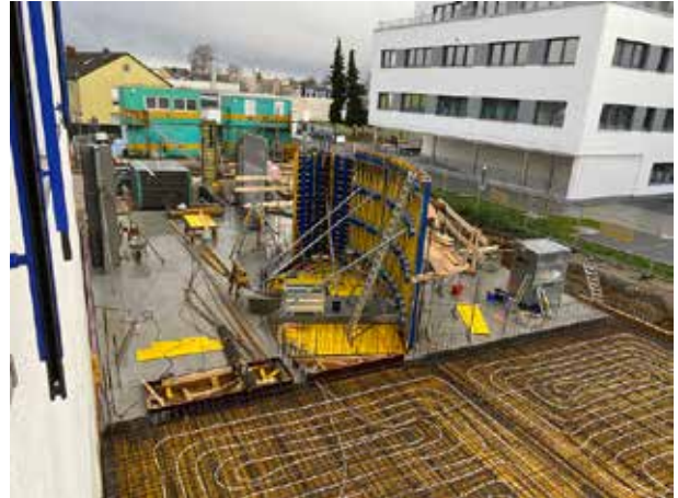
Les lignes de chauffage ont enfin été installées. Dans la zone avant, des travaux intensifs sont menés sur le coffrage de l'escalier.
