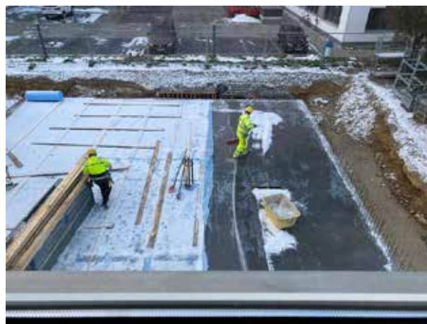
Avant de reprendre le travail, la neige doit être enlevée.
