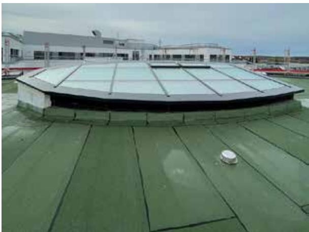
Pour voir la verrière de l'extérieur, il faut passer par l'échafaudage extérieur et monter jusqu'au toit.
