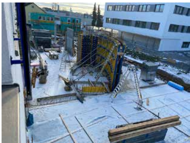
Le site de construction est encore un peu enneigé.
