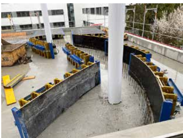
La base extérieure de l'ellipse du 1er étage est en train d'être maçonnée. Entre le plafond du premier étage et le sol proprement dit du premier étage, il y a de l'espace pour les lignes électriques et autres lignes d'alimentation.
