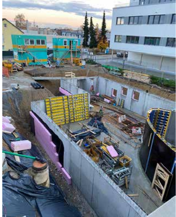
Les murs extérieurs sont isolés.
