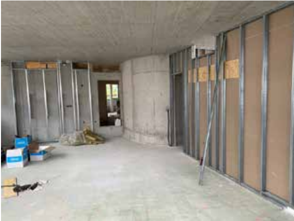
Les cloisons sèches sont en cours d'installation aux 1er et 2ème étages. Voici le futur salon - photographié depuis la sortie vers la terrasse du toit.
