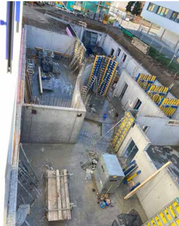
Presque tous les murs intérieurs du sous-sol sont finis. Seule une partie de l'ellipse de l'escalier est manquante.
