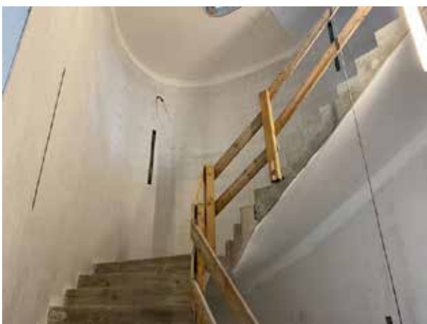
Le crépissage de la cage d'escalier est terminé - et on peut à nouveau accéder aux étages supérieurs par l'escalier.
