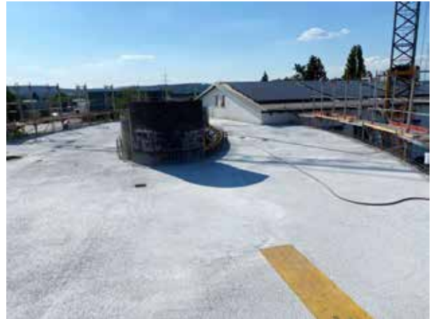
L'ellipse de la cage d'escalier au centre est ouverte vers le haut.
