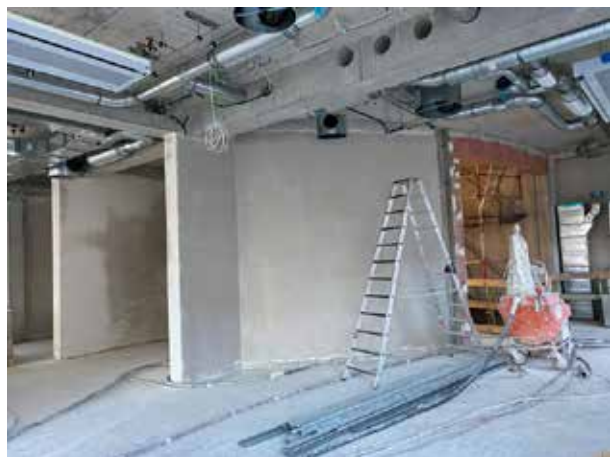
Maintenant, les murs du rez-de-chaussée sont également crépis.
