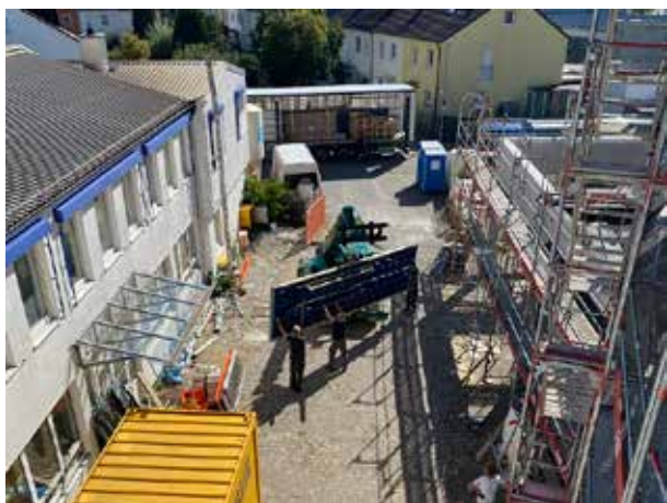
Les parties latérales de l'automate de stockage, longues de presque 7 m, doivent être transportées jusqu'au lieu de montage - ce qui n'est pas une mince affaire.
