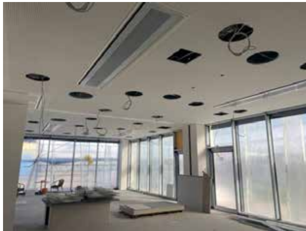
Un peu plus tard, le plafond insonorisant final est installé.
