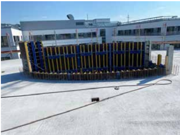
Les supports de la verrière inclinée doivent encore être bétonnés.
