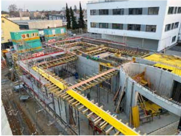
Les poutres de la dalle de la partie avant sont coffrées.
