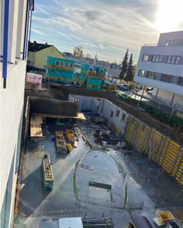
Le reste des murs extérieurs est en cours de coffrage et de bétonnage.
