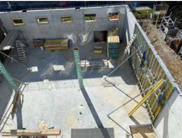
Vue du 2ème étage sur la zone de l'entrepôt.
