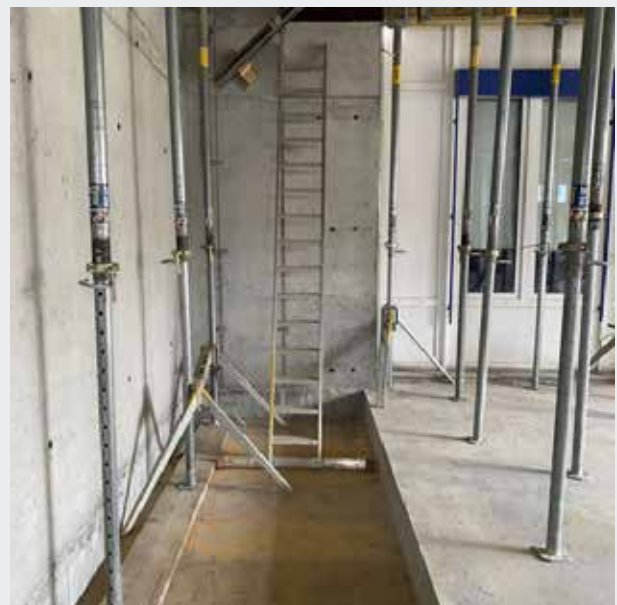
Ce sera finalement le site du dispositif de stockage, qui s'étendra du sous-sol au toit du premier étage.
