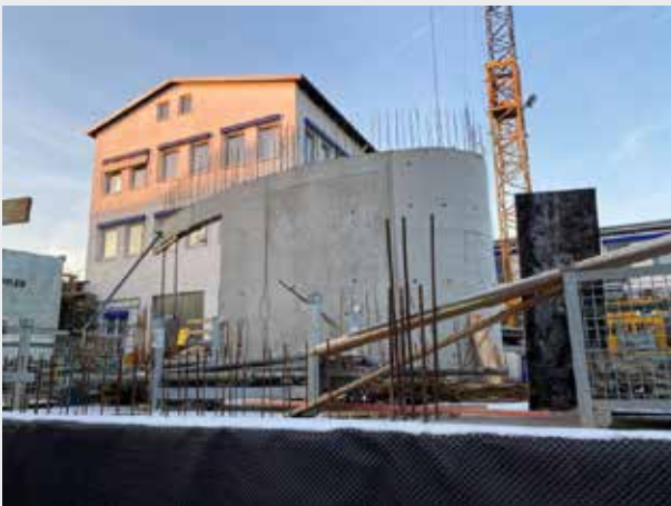
Vue de l'extérieur de l'ellipse de l'escalier – et du bâtiment existant.
