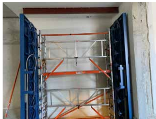
Pour la suite du montage, un échafaudage est d'abord monté - ici, vue sur celui-ci au rez-de-chaussée.
