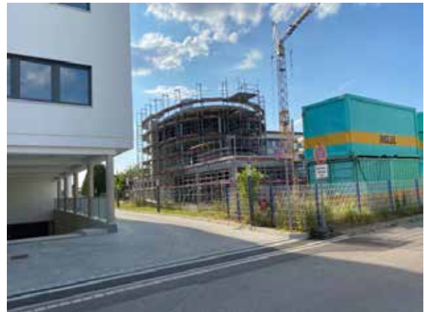
Le gros œuvre est maintenant terminé sur toute sa hauteur.
