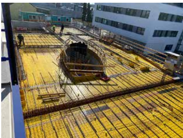
La première des nombreuses couches d'acier de construction est posée.
