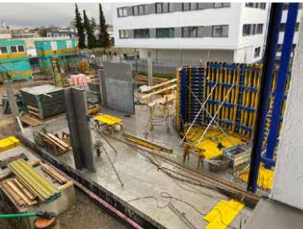
Les premières colonnes de la grande salle de réunion sont déjà en place (en haut à gauche).
