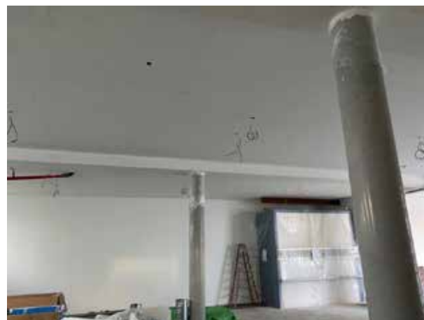
Notre distributeur automatique se trouve au fond de l'entrepôt, dans un coin.
