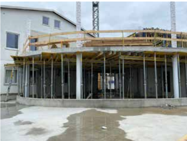
Vue depuis le toit du rez-de-chaussée, qui sera plus tard végétalisé, en direction du bureau de vente.
