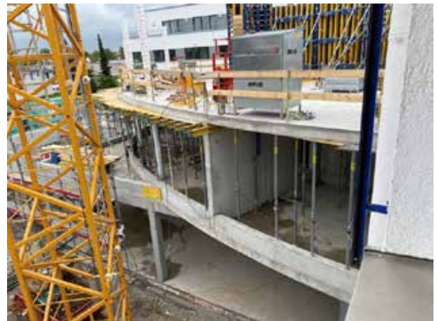
Vue du 2e étage de l'ancien bâtiment sur l'annexe.
