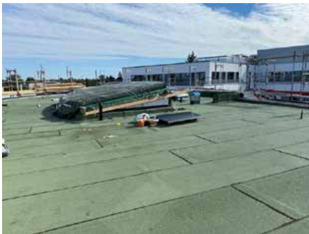
Il manque encore les vitres, de sorte que la construction du cadre a dû être emballée une nouvelle fois pour résister aux intempéries et à la pluie.
