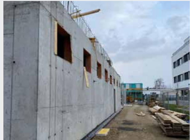
Le mur porteur vu de l'extérieur. Au cours de la semaine, le puits d'excavation a également été remblayé ici. L'échafaudage sera monté ici sous peu.
