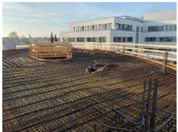
... jusqu'à ce que vous ne puissiez plus voir les planches de coffrage sur toute la structure métallique. Mais maintenant, tout est prêt pour le bétonnage.
