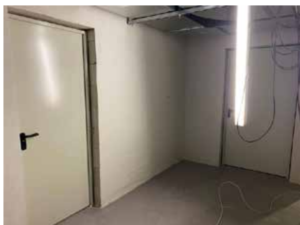
Dans la cave, les portes sont déjà installées.
