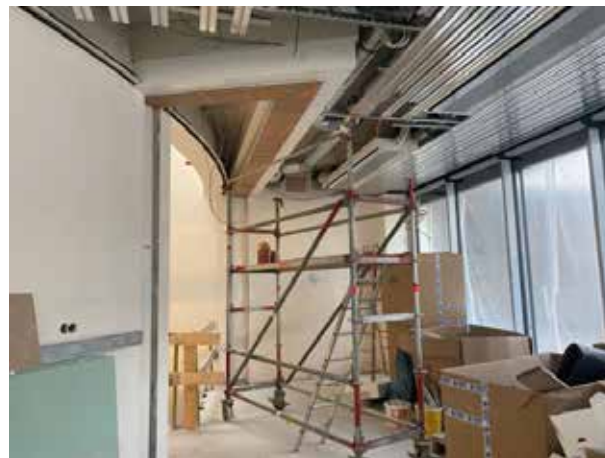
Dans la zone d'entrée, il manque encore le plafond final dans la zone arrière. Le rideau de protection incendie devant la cage d'escalier doit encore y être installé.
