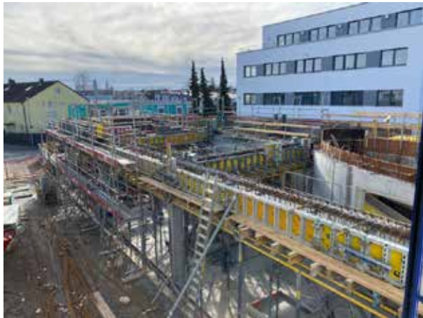
Les poutres sont bétonnées. Il faut maintenant retirer leur coffrage afin de pouvoir également poser le coffrage de dalle dans cette zone.
