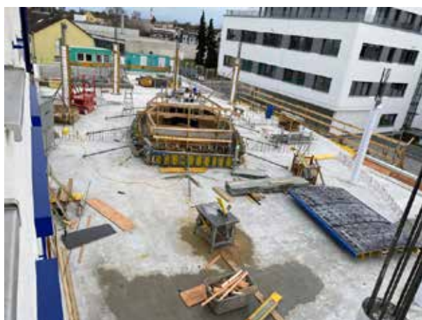
Le "pont" au-dessus de l'escalier est terminé.
