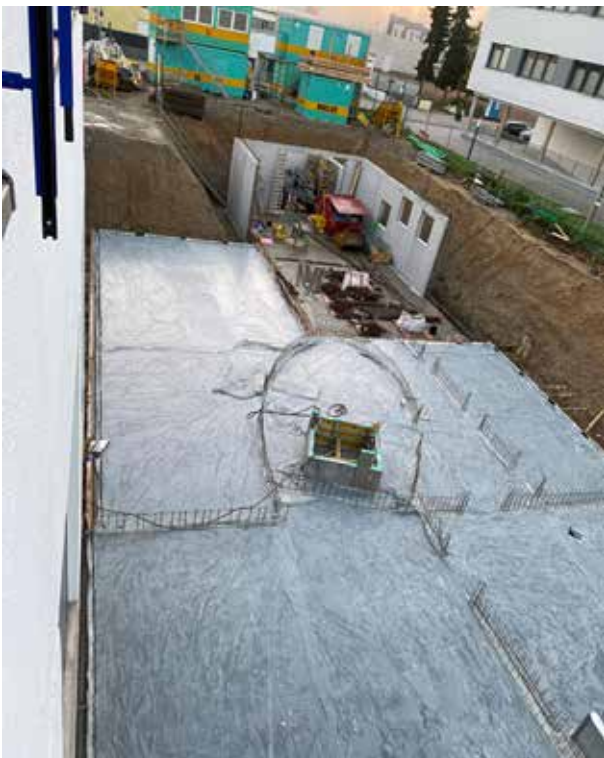
La dalle de plancher est prête. Les premiers contours sont visibles. Au centre, l'ellipse caractéristique du nouveau bâtiment. C'est ici que l'escalier sera construit.
